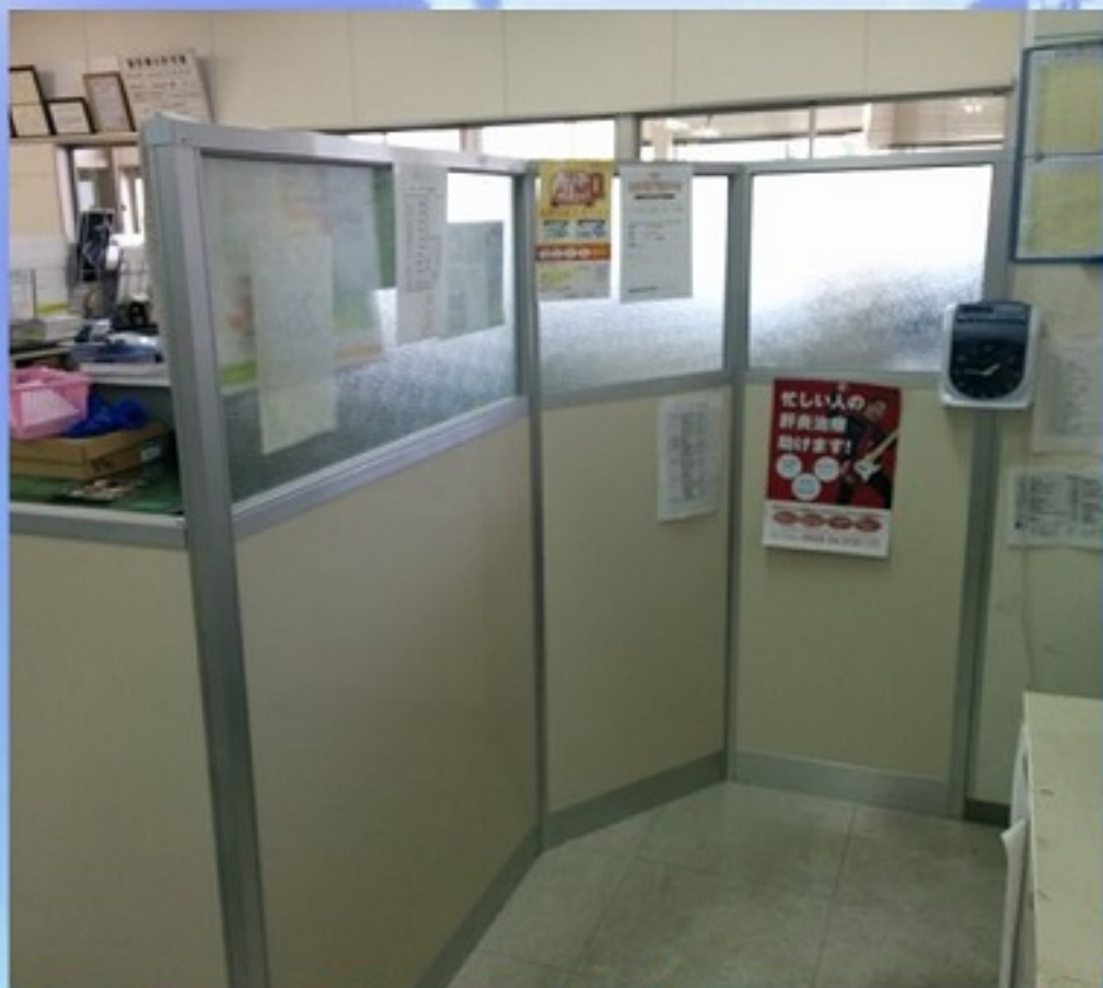
パーティション工事
