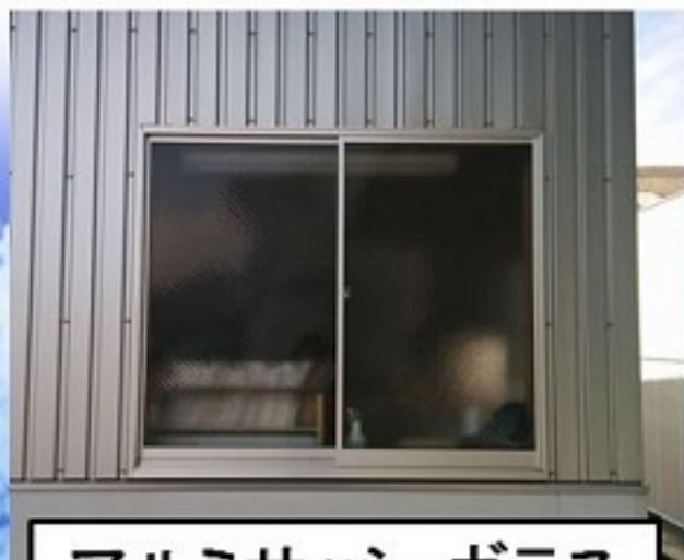
アルミサッシ・ガラス 網戸工事
