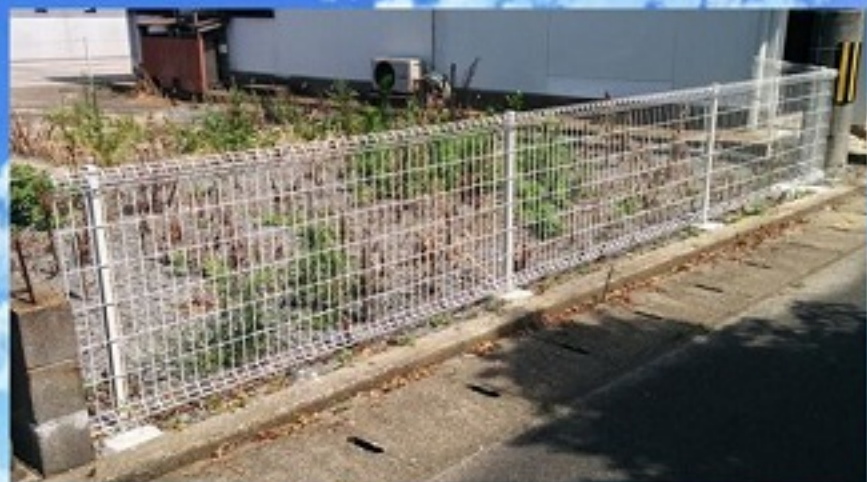
フェンス工事
