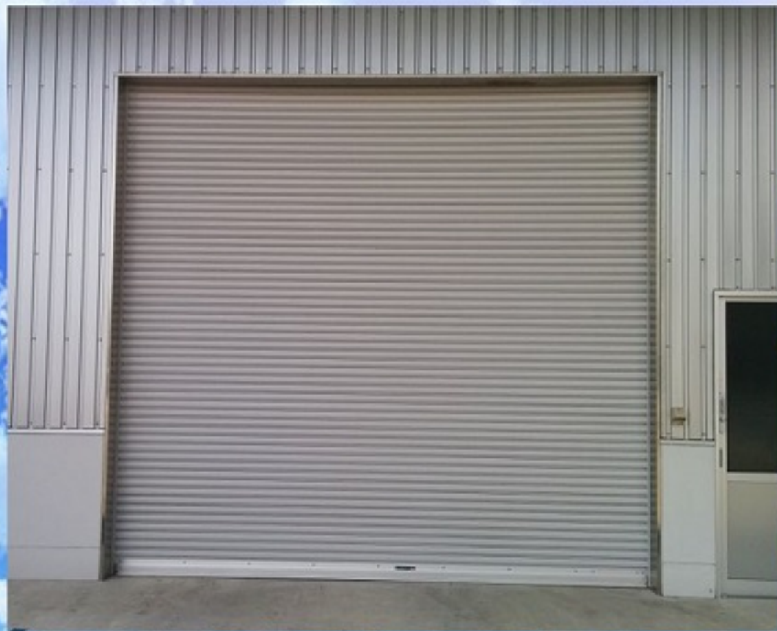
電動シャッター工事
