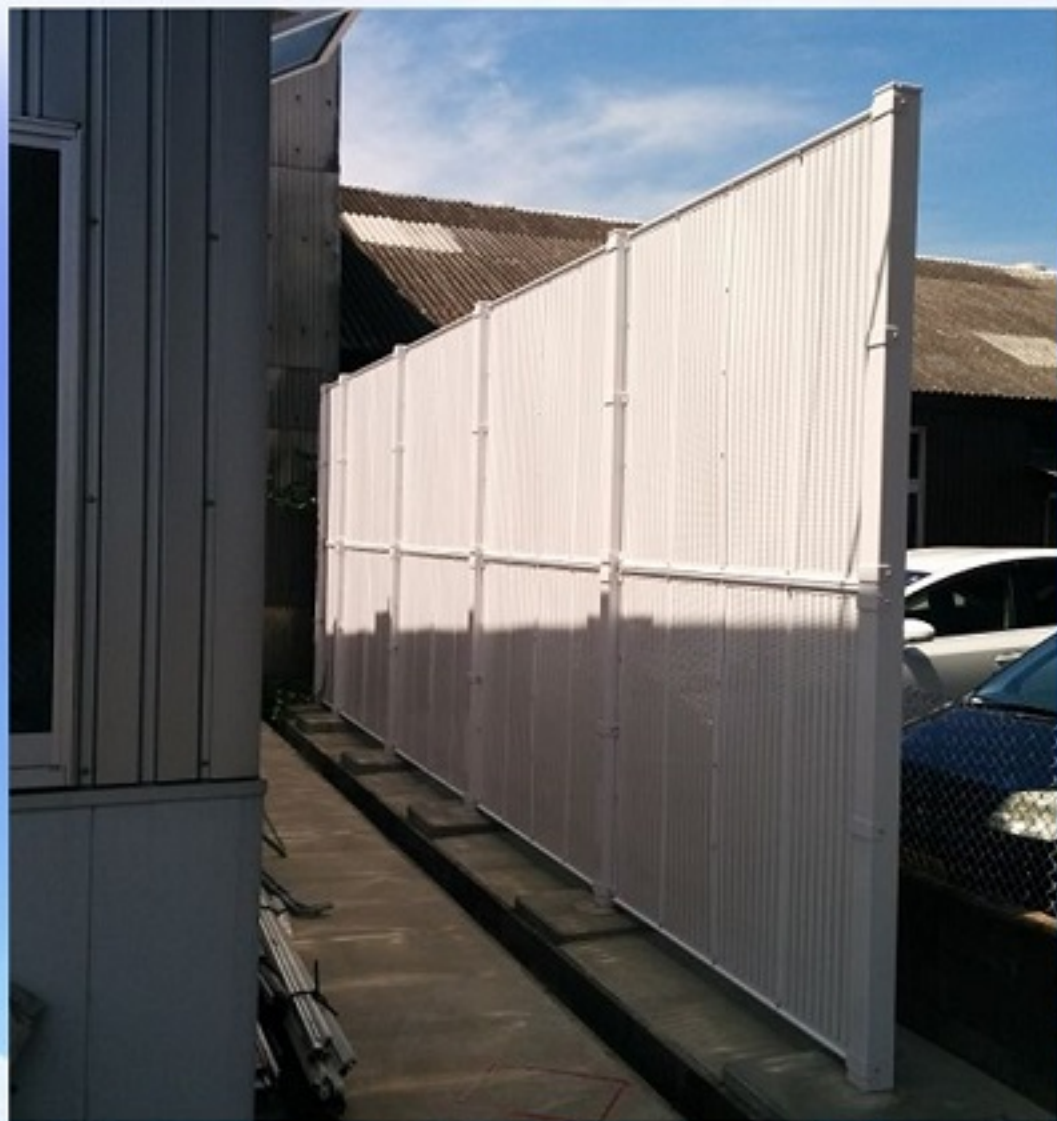
防風フェンス工事
